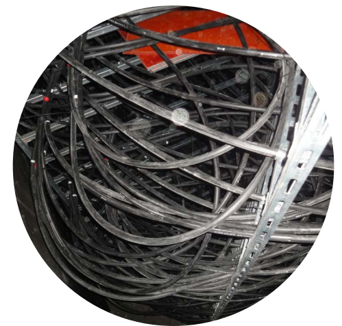
Blick in den Eisspeicher (im Bau ohne Wasser)
